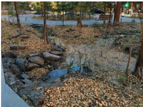
Figura 72. Após a plantação, as águas pluviais de 1 000 m<sup>2</sup> de superfície pavimentada foram conduzidas para o jardim de chuva e infiltradas, evitando inundações, fenômeno recorrente na região.
